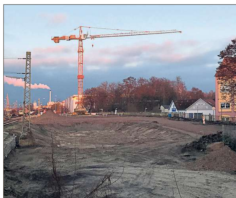
Der Baukran steht auf dem Gelände am Langer Weg. Der symbolische erste Spatenstich für das Millionen-Projekt soll im Januar folgen.
