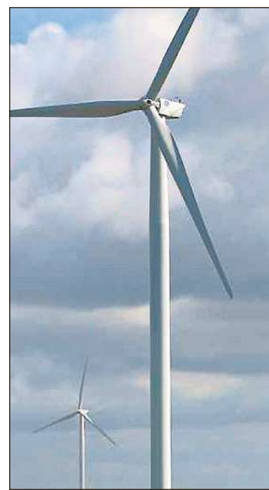
Drei Windanlagen des Typs GE Wind Energy, GE 2.5-120 sollen errichtet werden.
