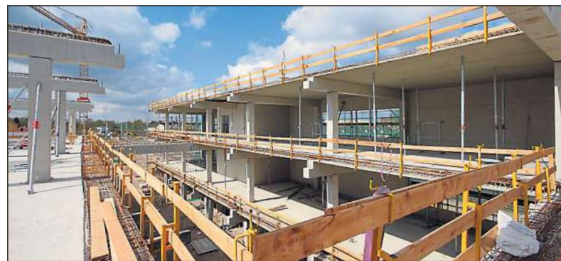
Das Dachgeschoss muss noch komplettiert werden. Das Fitness-Studio Fit X nutzt beide Etagen, insgesamt rund 2300 Quadratmeter.
