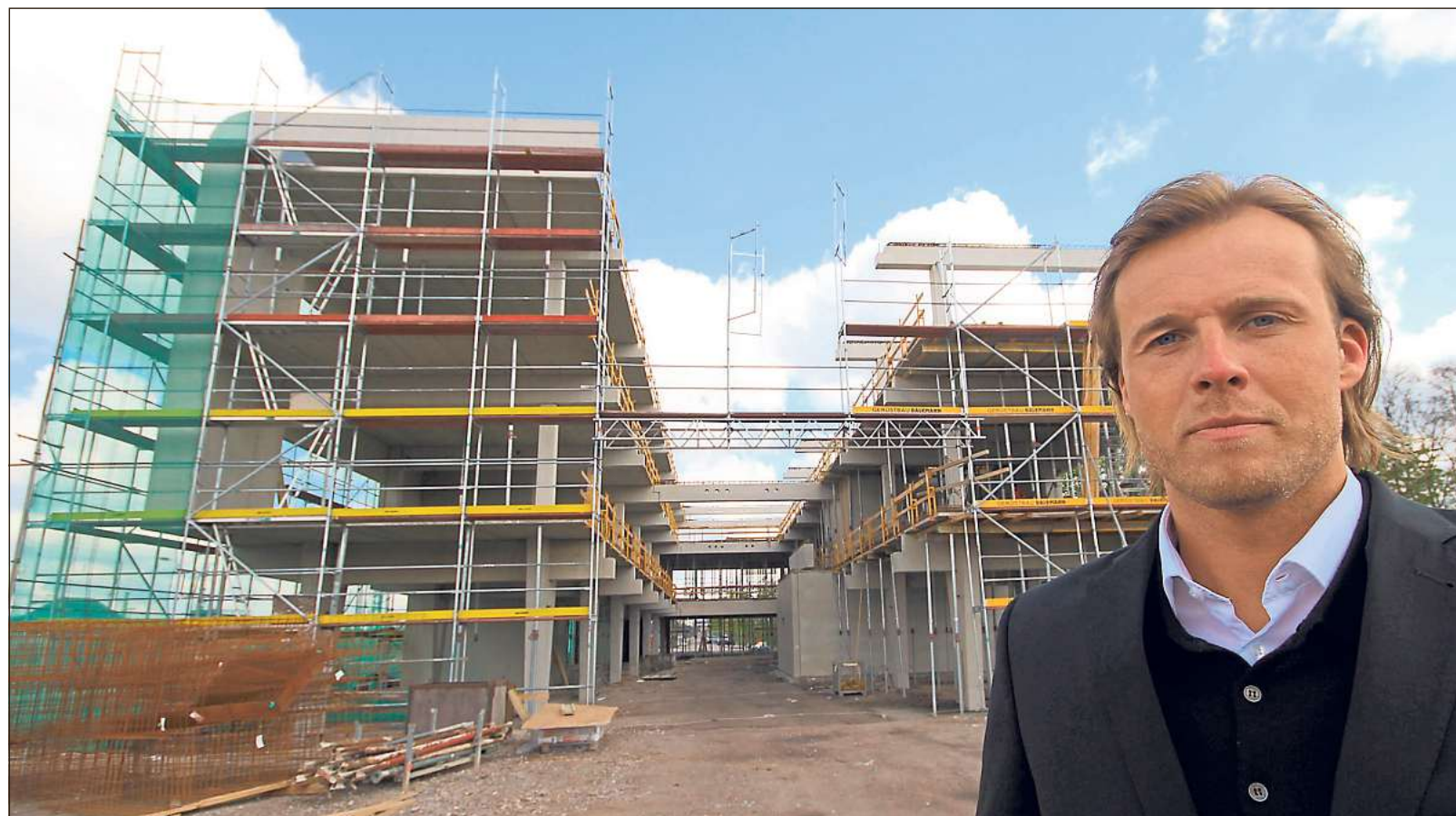
Mit dem Bauverlauf am Gleis 13 zufrieden: Rick Mädél vor dem Rohbau des Hauses IV am Langen Weg, der im Mai abgeschlossen sein soll. Dort zieht auf zwei Etagen die Fitness-Kette Fit X ein. Bilder: Dinkels (2), Dünhölter
