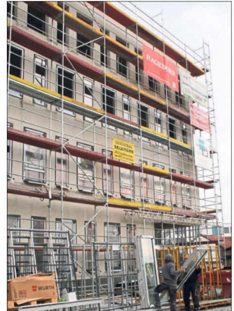
Haus III nimmt langsam Gestalt an. Dort wird bald die Agentur für Arbeit einziehen. 40 Prozent der Fläche sind noch frei.
