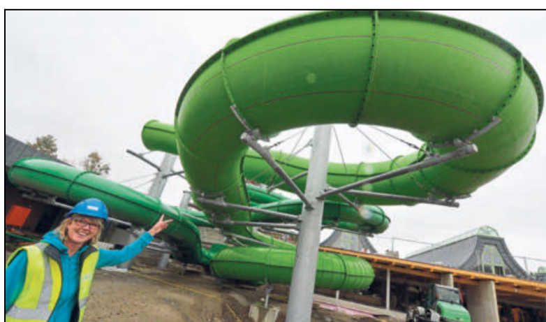
Der Umbau der »Welle« – hier Leiterin Ursula Kriefft-Meier mit den Riesenrutschen – läuft auf Hochtouren. Foto: Wolfgang Wotke
