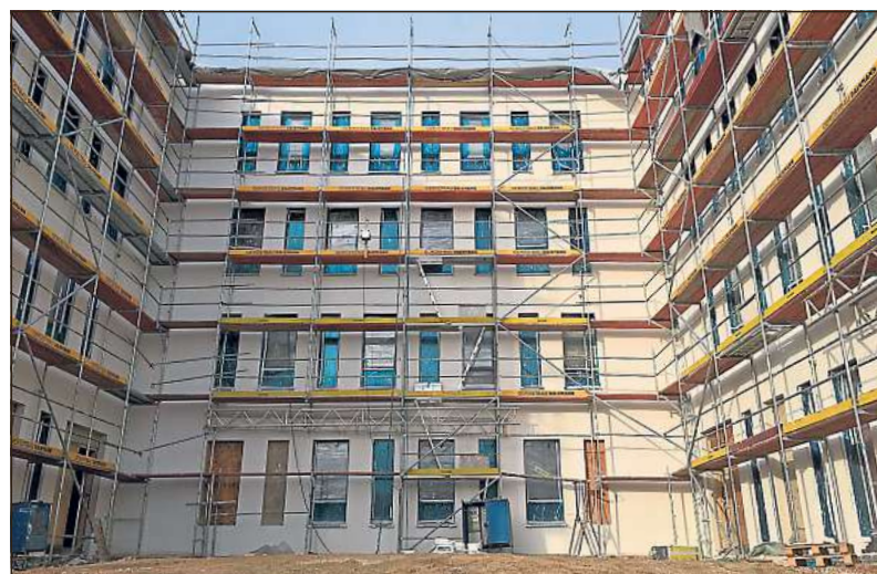
Im März soll das Haus III des Projekts Gleis 13 am Langen Weg fertiggestellt werden. Zwei Drittel der Fläche nutzt die Arbeitsagentur. Zu den übrigen Flächen hält sich Hagedorn noch bedeckt. Bild: Dinkels
